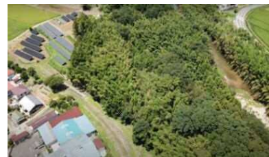
霞堤を上空から見た様子。川と霞堤の間には竹林や森が広がっている。右側が安濃川 左側が堤防（霞堤） （三重大学附属小学校前田昌志教諭撮影）
