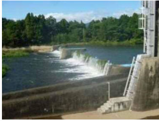
第三頭首工全体の様子
