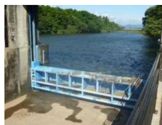
第三頭首工の泥吐け
